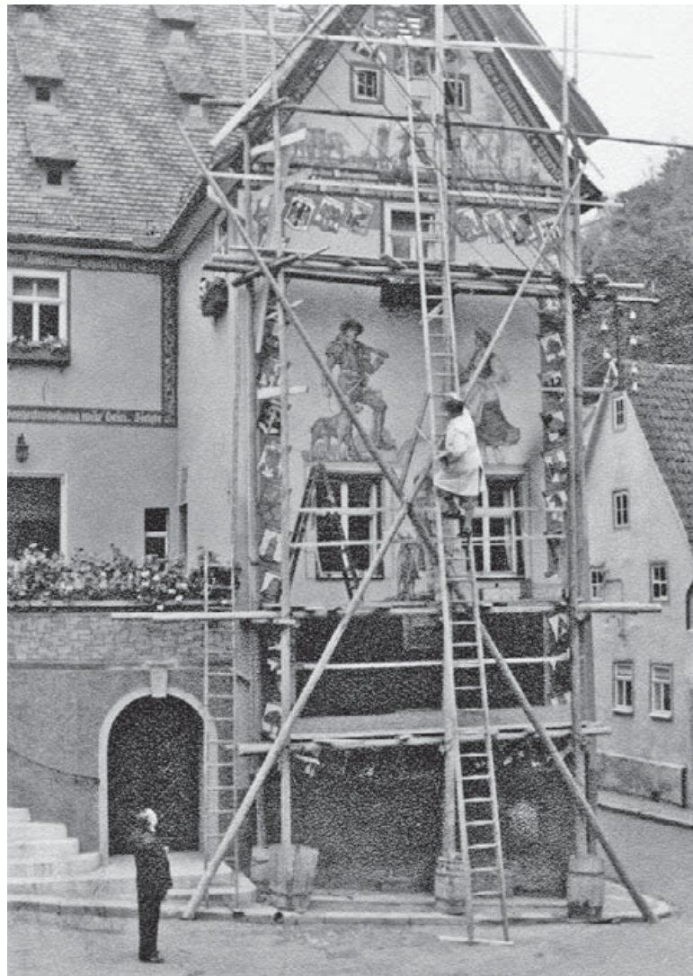
Gut gerüstet: Wilhelm Jöker bemalt die Fassade des Rathauses von Ziegenrück.
